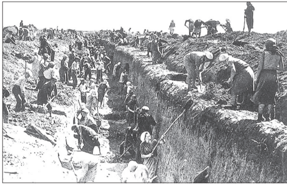
Рытье оборонительных сооружений
